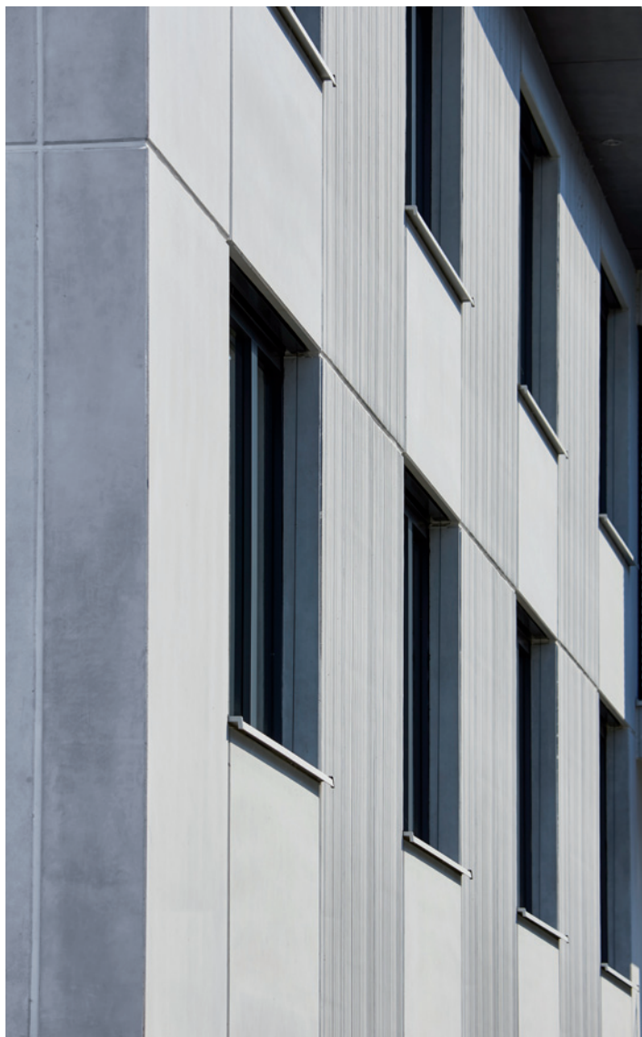
Beton schafft individuellen Charakter und anspruchsvolle Oberflächen durch Matrizentechnik.
