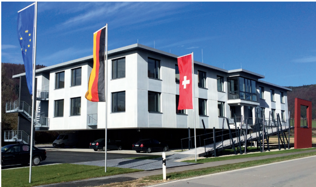
Elsäßer Verwaltung – Null-Emissionsgebäude im Passivhaus-Standard. Fassade mit Thermowänden und strukturierten Elementen an der Hauptfassade.
